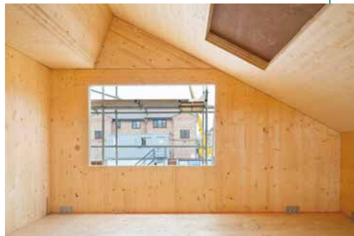
Figura 5. Vista dell'ultimo piano del blocco D prima della posa della copertura. (Foto: Agnese Sanvito)
