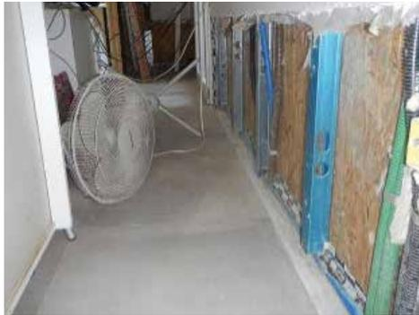
Nel caso dell'edificio a struttura platform-frame, oltre alla demolizione dei cappotti esterni e dei rivestimenti interni, è stato necessario aprire da un lato la parete per estrarre il coibente (lana di roccia) presente all'interno dello spessore del telaio e che si presentava completamente imbibito d'acqua.
